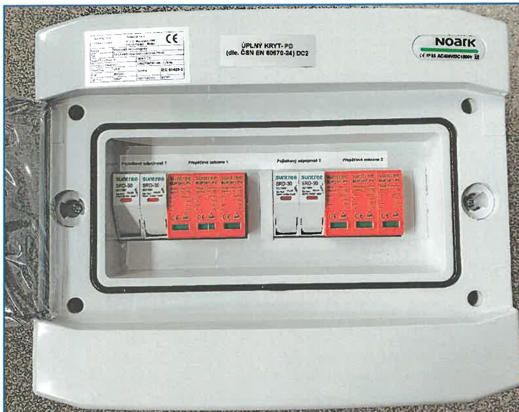
Obr. 3 - Rozváděč RS-FVE-DC2 (otevřený)
